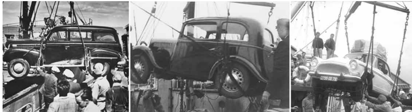
Evolution de l'embarquement des véhicules - de gauche à droite : des madriers sous le châssis, puis des cordages sous les roues et, plus tard, des filets sous les pneus. Photos : F. Pillet, J. Teraud, V. Roussière - Collection des musées du département de la Vendée.
